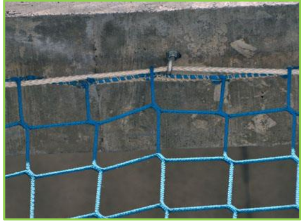
Şekil 17: Güvenlik ağının sabitlenmesi
