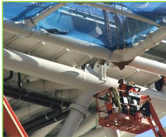
Şekil 18: Yükseltilebilir iş platformu aracılığıyla güvenlik ağı kurulumu
